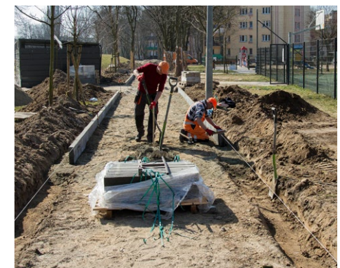
Prace przy realizacji drugiego etapu Centralnego Parku Rekreacji
